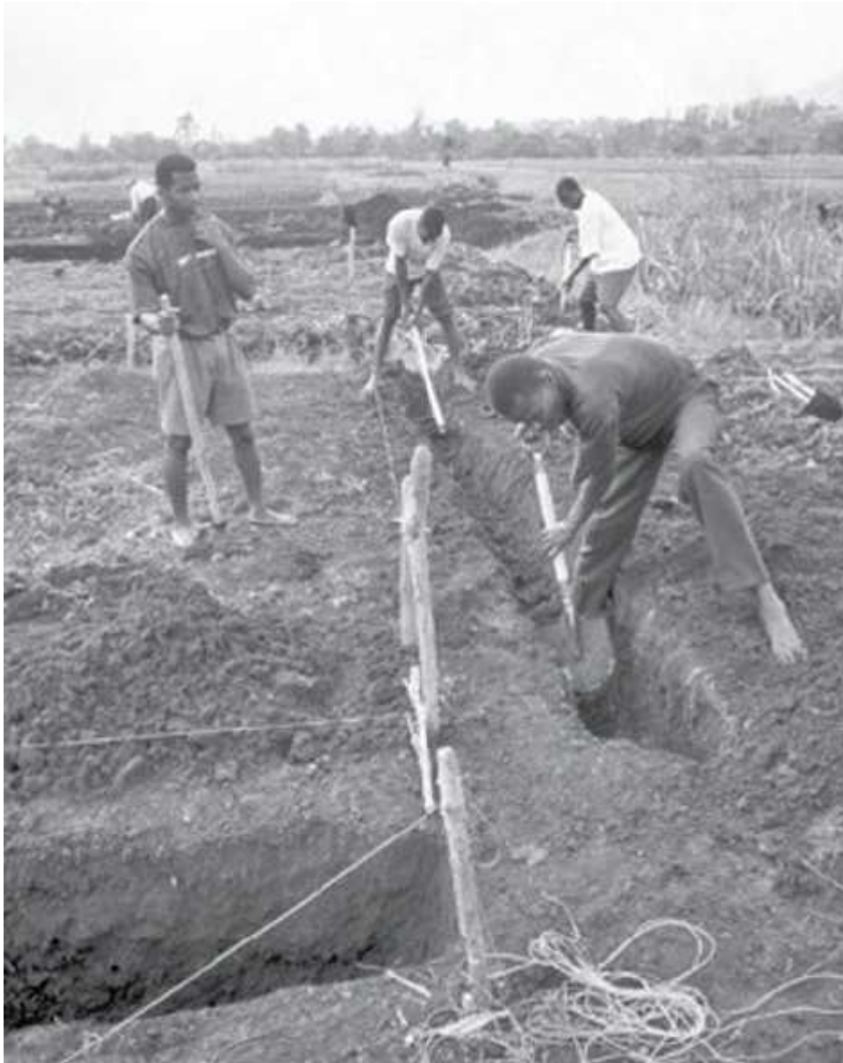
Mambo zimeshapigiliwa na kazi ya uchimbaji imeshaanza, udongo unarushwa kwenye kiini kutengeneza ukingo
